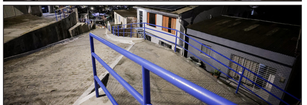
Rua Najá recebeu obras de pavimentação e drenagem para melhorar a mobilidade e reduzir alagamentos no bairro
